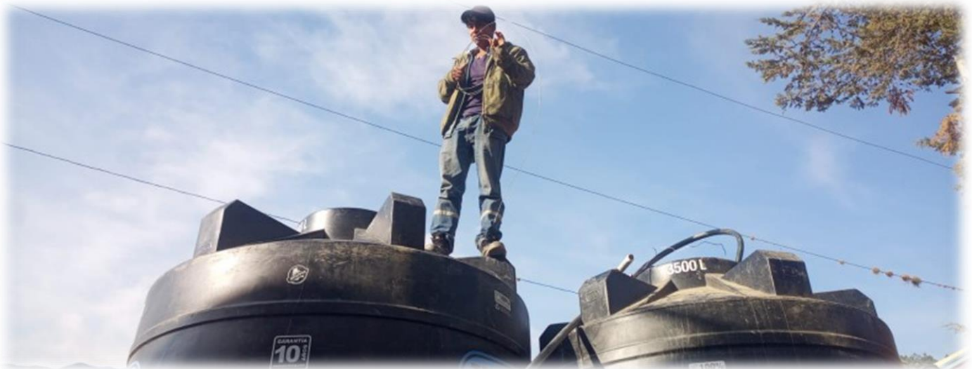
PVC-Tanks, um Wasser während der Nächte zu speichern. Sie stehen am selben Ort wie der Brunnen.
