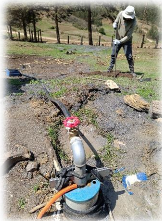
Das Wasser wird durch 1,5"-Kunststoffrohre bis nach Independencia geleitet.
