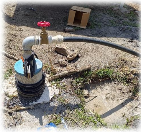
Das solarbetriebene Pumpsystem, welches das Wasser mit einer 2-hPa-Pumpe aus 60 Metern Tiefe hinaufpumpt.
