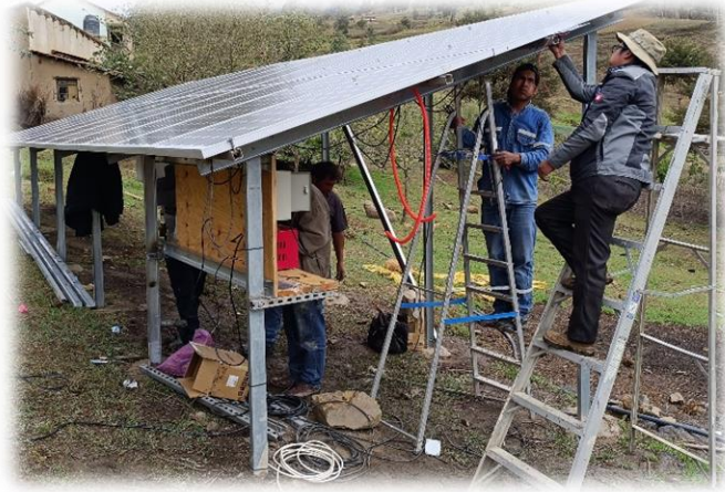
Das solarbetriebene Pumpsystem, welches das Wasser mit einer 2-hPa-Pumpe aus 60 Metern Tiefe hinaufpumpt.
