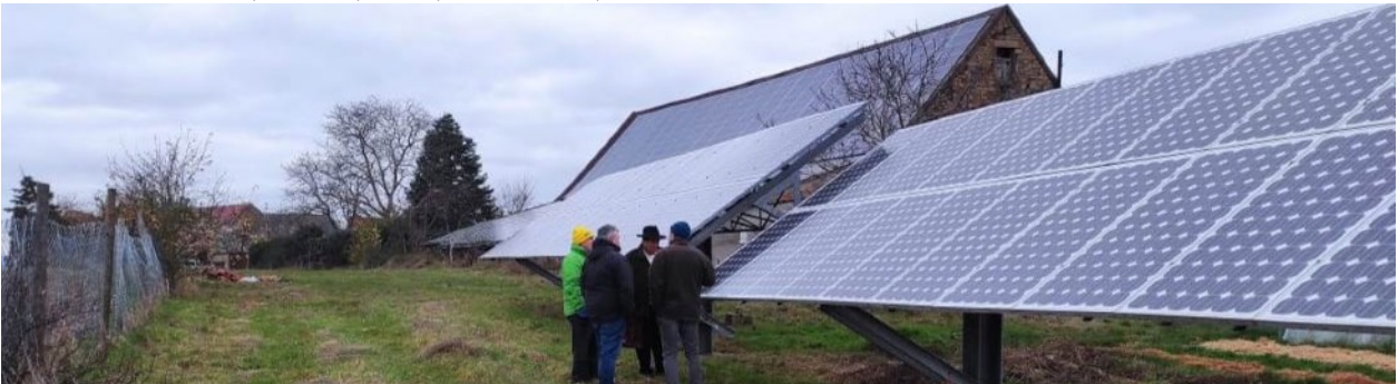
NNOBERT WILLENBACHER haciendo la ENTREGA DE 858 PANELES. MISSION IMPOSIBLE ! CULMINA: 150 FAMILIAS TIENEN LUZ FOTOVOLTAICA, EN EL MUNICIPIO DE INDEPENDENCIA.
